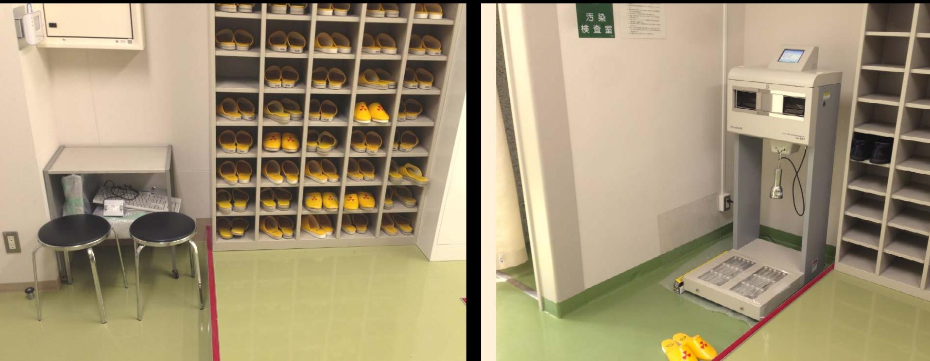
奥の実験室へ入る際は、黄色スリッパに履き替える。(履物底にRI汚染があつても、ここで床の汚染が止められる。) ハンドフットクロスマニタで手やスリッパ底などの汚染検査を行う。
